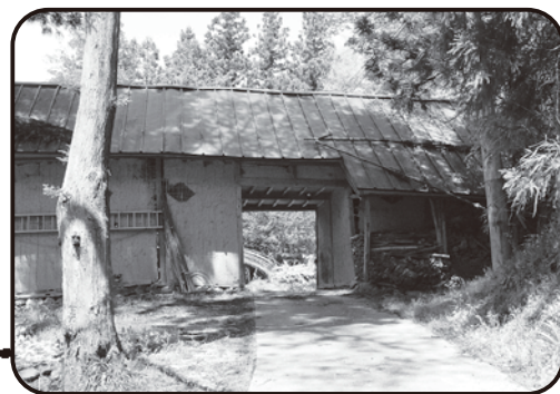
土壁の長屋門
