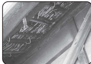
麻殻で葺いた屋根下地
